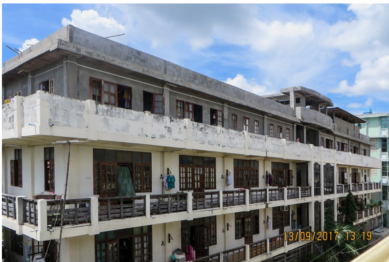
01_Girls dormitory vor der Renovierung
