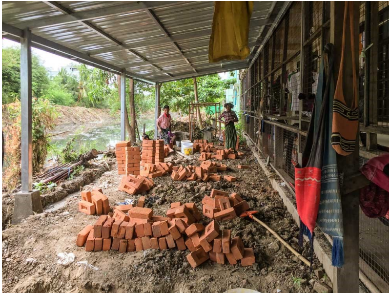
12_Vor der Fundamentierung der neuen Küche
