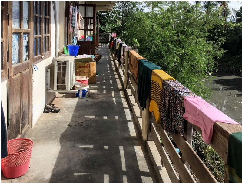
04_Bisher- die Kleider trocknen auf der Brüstung
