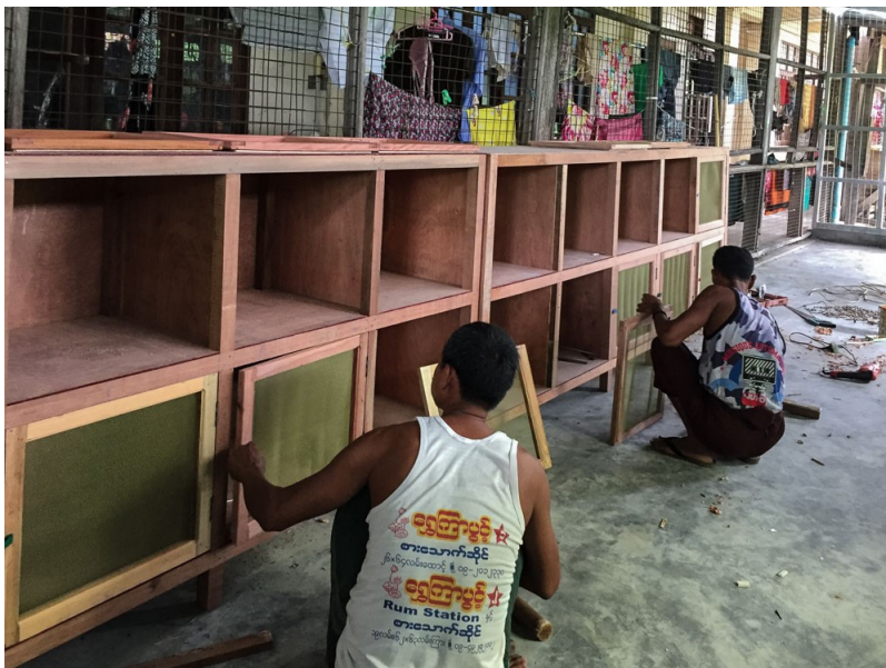
13_Die Küche erhält neue Einbauschränke
