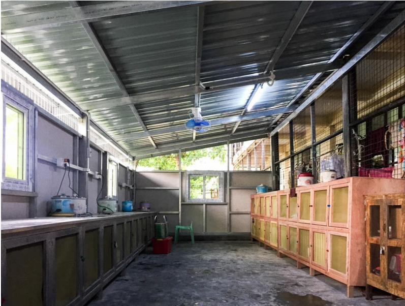
14_Die neue Küche ist fertig eingerichtet
