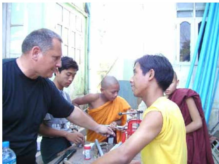
Martin Weiskopf, Wasser, Rohre, Installationen
