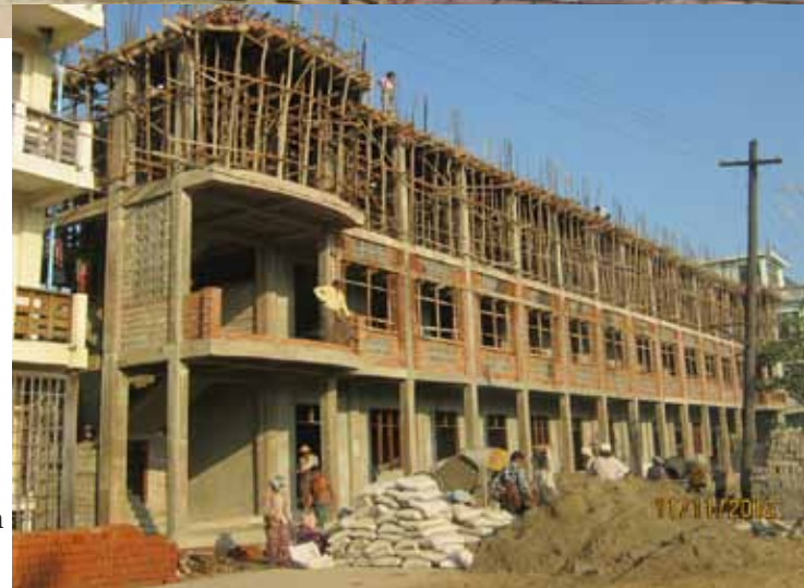
Mit Chan Chan von der Grundsteinlegung bis zum 3. Stock, Stand November 2012
