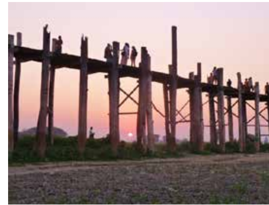
Die U-Bein-Brücke, die den Taungthaman-See in der Nähe von Amarapura quert. Die 1,2 Kilometer lange Brücke wurde um 1850 erbaut und gilt als älteste und längste Teakholz-Brücke der Welt.
