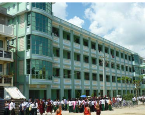
Das NTTC 2019, aus Fördermitteln von uns gebaut 2013
